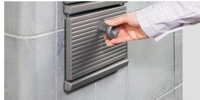
Säädä huoltoluukku hieman raolleen huoltoluukun ilmansäätimestä.
