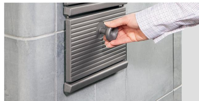
Öppna serviceluckan lite på glänt med hjälp av luftreglaget. Under eldningen och även långt efteråt är luckan varm. Var försiktig med den varma luckan och rör endast handtaget och luftreglaget. Vid behov använd en hanske som tål värme.
